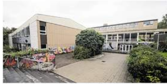
Morgen sollen die ersten vorbereitenden Maßnahmen zum Abriss des alten Alsdorfer Gymnasiums erfolgen. FOTO: TIM GRIESE
