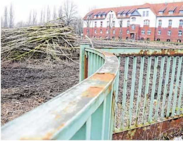
Vorbereitungen für den Bau des Kubiz-Sportplatzes laufen: Das Holz der gefällten Bäume bleibt noch bis Ende des Monats liegen. Foto: V. Müller
