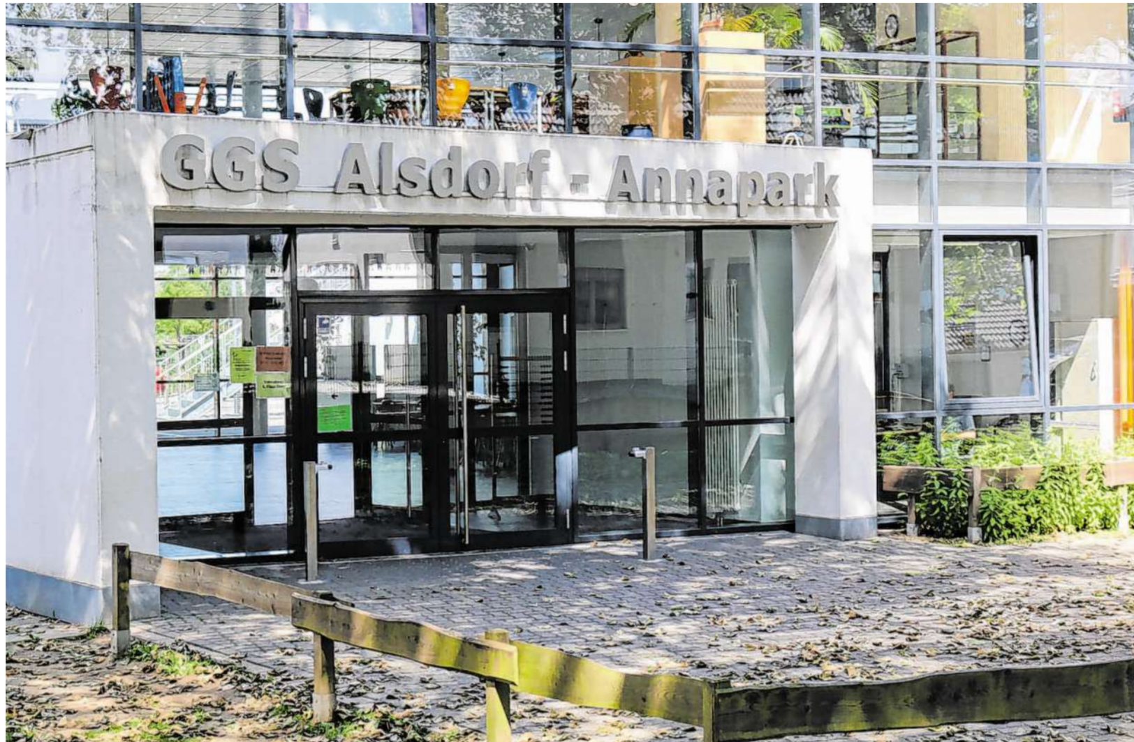
Die Gemeinschaftsgrundschule Alsdorf-Annapark ist eine der zwei Schulen, an denen das Energie-Monitoring getestet wird. Die an die EWV überlieferten Daten können jederzeit von der Grund- und Stadtentwicklung abgerufen werden. Foto: Tocay
