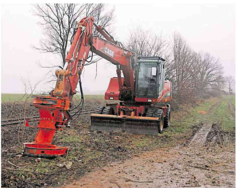
Bis Ende Februar, also vor Beginn der Brutzeit, sollen laut EVS die Rodungsarbeiten zwischen Siersdorf und Kellersberg abgeschlossen sein. FOTO: KARL STÜBER
