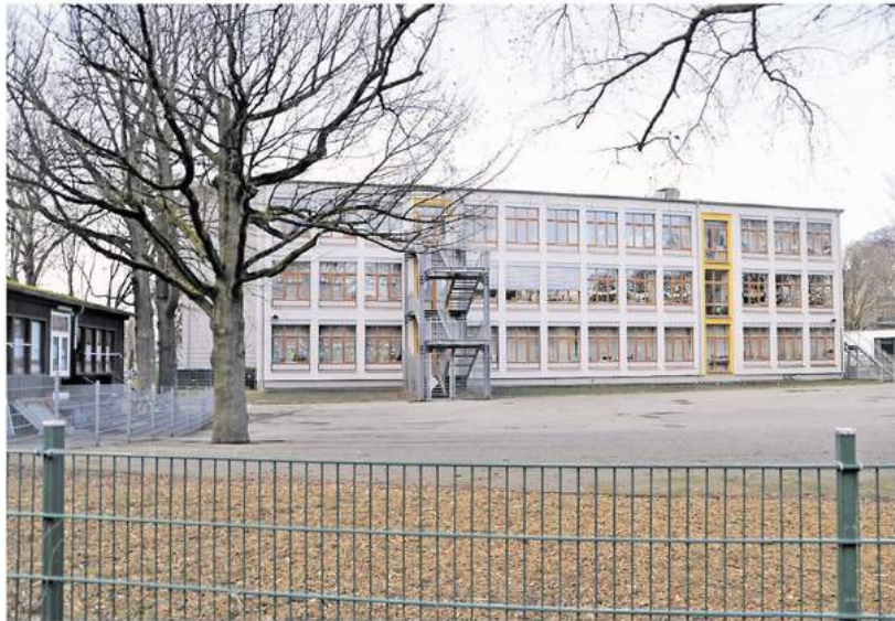
Profitiert von Mitteln aus dem Förderprogramm „Gute Schule 2020“: Rund 600.000 Euro werden in Betonsanierung und Brandschutz der Gemeinschaftsgrundschule Blumenrath in der Poststraße investiert.
