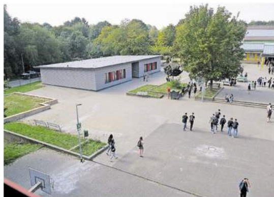
Blick aus dem Altbau auf den Neubau: Groß ist die Erweiterung an der Südseite des Schulgeländes nicht, aber doch überaus wichtig für die weitere Entwicklung der Gustav-Heinemann-Gesamtschule.
