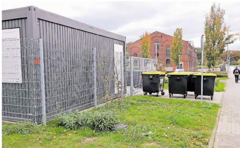
Der Betriebshof des Kultur- und Bildungszentrums in Alsdorf (Vordergrund) in der Nähe der Kraftzentrale (Hintergrund) muss weichen, weil hier der Neubau der Jugendkunstschule „Aber Hallo“ entsteht.
