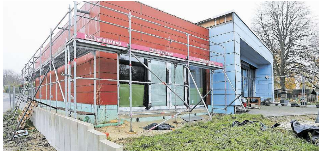
Die evangelische Kita in Ofden: Der Neubau einer Gymnastikhalle sollte im März bereits gehalten sein, aber die Gerüste stehen noch, die Halle ist noch nicht nutzbar.
