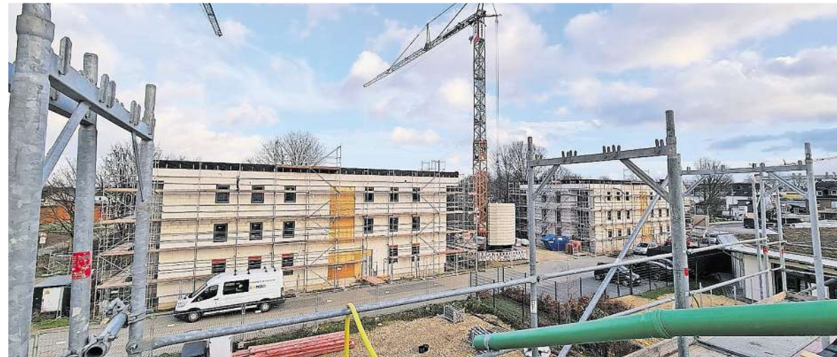
Die Rohbauten an der Herzogenrather Straße stehen, im Sommer sollen die Bauarbeiten abgeschlossen und die 36 Wohnungen bezugsfertig sein.
