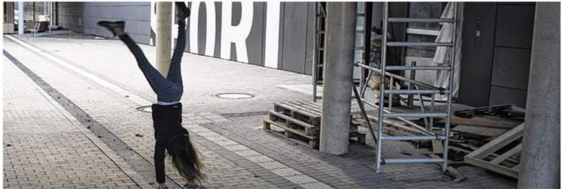
Rundgang durch den Neubau: Im Foyer zum Außenbereich ist der Boden frisch gespachtelt, eines der Treppenhäuser hat die dunkelrote Grundierung erhalten, die Fassade ist fertig, der Schwingboden ist in einem Teil der Turnhallen verlegt, orangenes Linoleum erhalten die Flure (naturwissenschaftliche Räume säurebeständigen blauen Boden), „Sport“ wird bislang nur außen betrieben und die Stühle sind bereits geliefert (v.o.l.). Fotos: V. Müller
