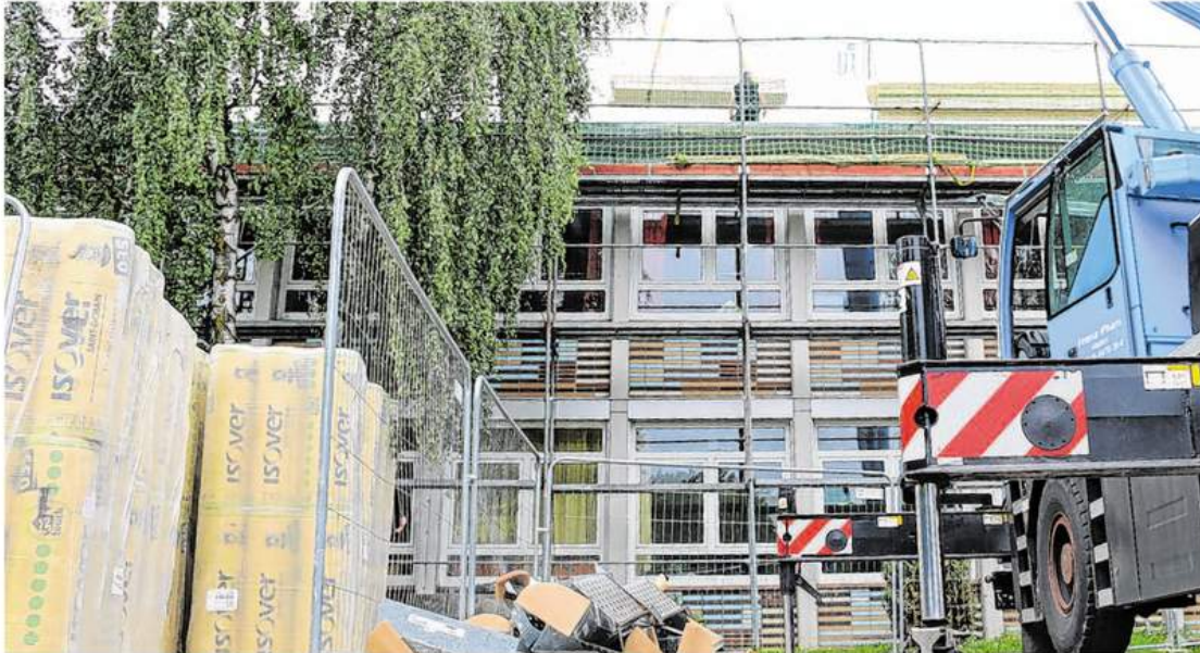
Die Arbeiten auf dem Dach der Grundschule in Ofden sind in vollem Gange: Trapezprofiltafeln aus Aluminium und eine Geschosdeckenisolierung werden angebracht. Foto: Nadine Tocay
