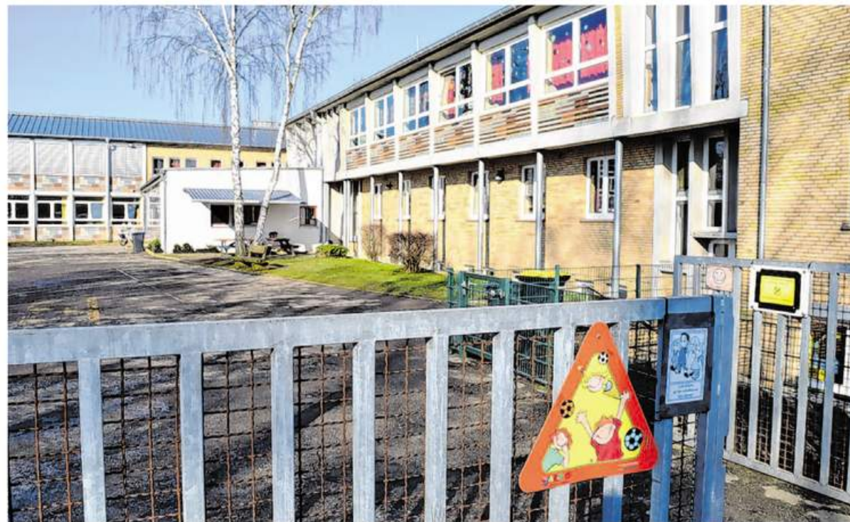
Häkchen dran: Die energetische Sanierung der Grundschule Ofdon ist soeben beendet. Derweil gehen die Arbeiten an anderen öffentlichen Gebäuden in Alsdorf weiter. Foto: Verena Müller
