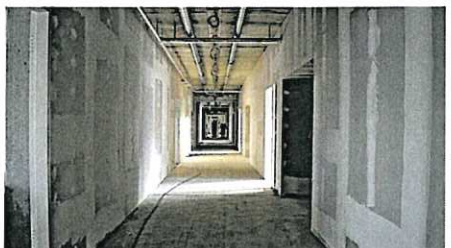
In Fluren und Klassenräumen werden die Trockenarbeiten gemacht: Wände verkleidet und gestrichen, Akustikdecken eingezogen.
