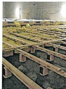
Schritt I: Auf Holzblöcke werden Latten genagelt und die Hohlräume mit Dämmmaterial gefüllt.
