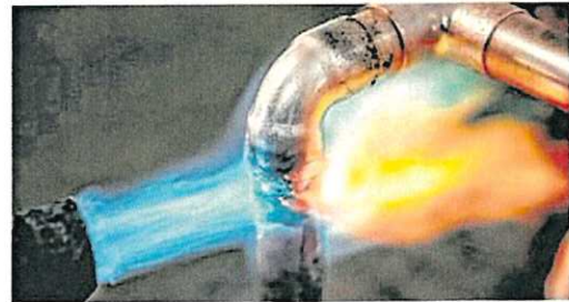
Kostenfrage: Gelötete Kupferrohrverbindungen (Bild) sind aufwendig und lohnkostenintensiv. Deshalb wurden bei den Wasserleitungen im Kultur- und Bildungszentrum Alsdorf Pressverbindungen geschaffen. Ein durchgängiges Verfahren – mit fatalen Folgen. Foto: imago/stock&people
