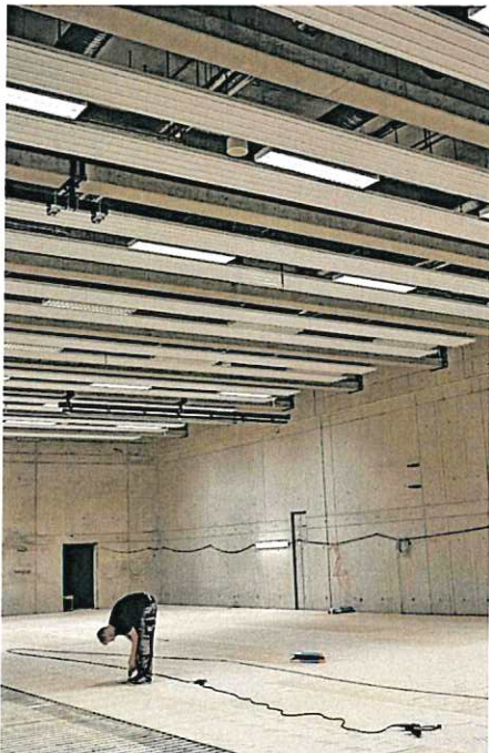
Schritt II: Dünne Holzböden werden in mehreren Schichten festgebohrt. Die Deckenstrahlheizung ist übrigens auch zu sehen: in weißen Bahnen.
