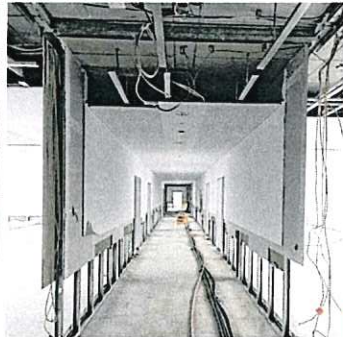
Kommando zurück: In den Turnhallen wurde der bereits verlegte Schwingboden wieder entfernt (oben). In vielen Fluren mussten unter anderem Trockenbauwände und Abhangdecken zurückgebaut werden.
