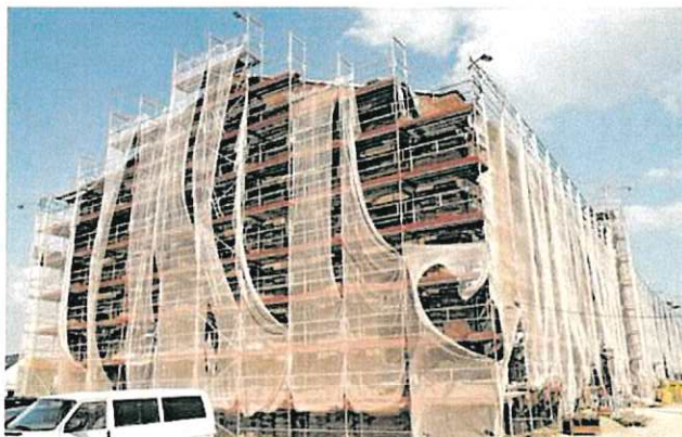
Baustelle Kraftzentrale: Weil die Immobilie nicht rechtzeitig für den Schulbetrieb fertig wird, müssen Container gekauft werden. Foto: Karl Stüber
