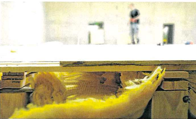
Der Schwingboden in den drei Turnhallen ist bald fertig. Im Wesentlichen sind es drei Arbeitsschritte:
