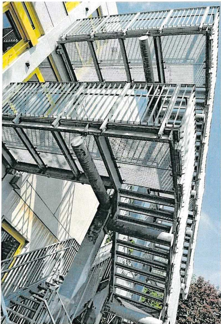
Treppenturm an einer der Außenfassaden der Gustav-Heinemann-Gesamtschule: Sie ist das Objekt mit den umfangreichsten und teuersten Brandschutzmaßnahmen, die derzeit in Alsdorf umgesetzt werden. Fotos: vm
