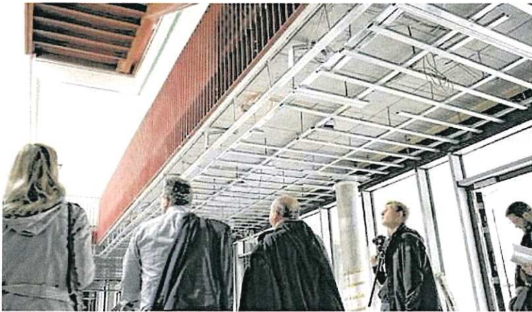
Demontage im neuen Kultur- und Bildungszentrum Alsdorf abgeschlossen: Unter anderem musste nach dem Auslaufen erheblicher Wassermengen die abgehängte Decke bis aufs „Gerippe“ entfernt werden (links). Es wird noch bis Sommer 2017 dauern, bevor Gymnasium und Realschule auch Sportanlagen im Untergeschoss nutzen können. Fotos (3): Karl Stüber
