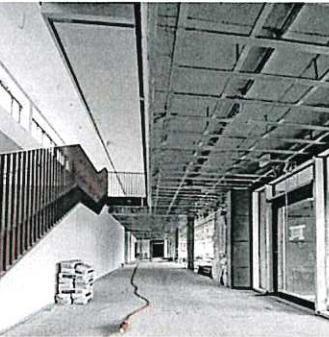
Kommando zurück: In den Turnhallen wurde der bereits verlegte Schwingboden wieder entfernt (oben). In vielen Fluren mussten unter anderem Trockenbauwände und Abhangdecken zurückgebaut werden.
