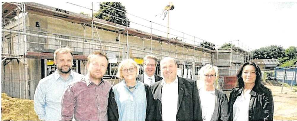
Der Kita-Neubau in Ofden nimmt Form an; Die Beteiligten feierten jetzt Richtfest.
