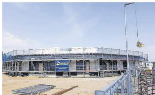
Der Bau bietet Platz für sechs Gruppen, die Räume sind um einen zentralen Flur herum angeordnet, der auch als Versammlungsraum dienen soll.
