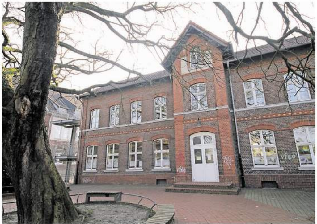
Die Gemeinschaftsgrundschule Schaufenberg wird weiter saniert. Diesmal steht der Schulhof im Mittelpunkt. Foto: Tim Griese
