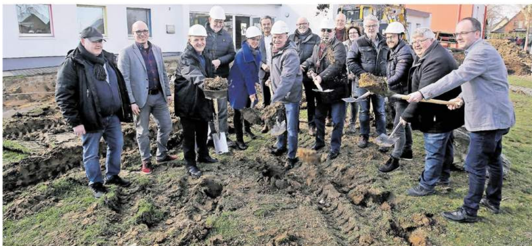
Die Projektbeteiligten beim Spatenstich: Die Offene Ganztagsgrundschule in Alsdorf-Begau wird erweitert.
